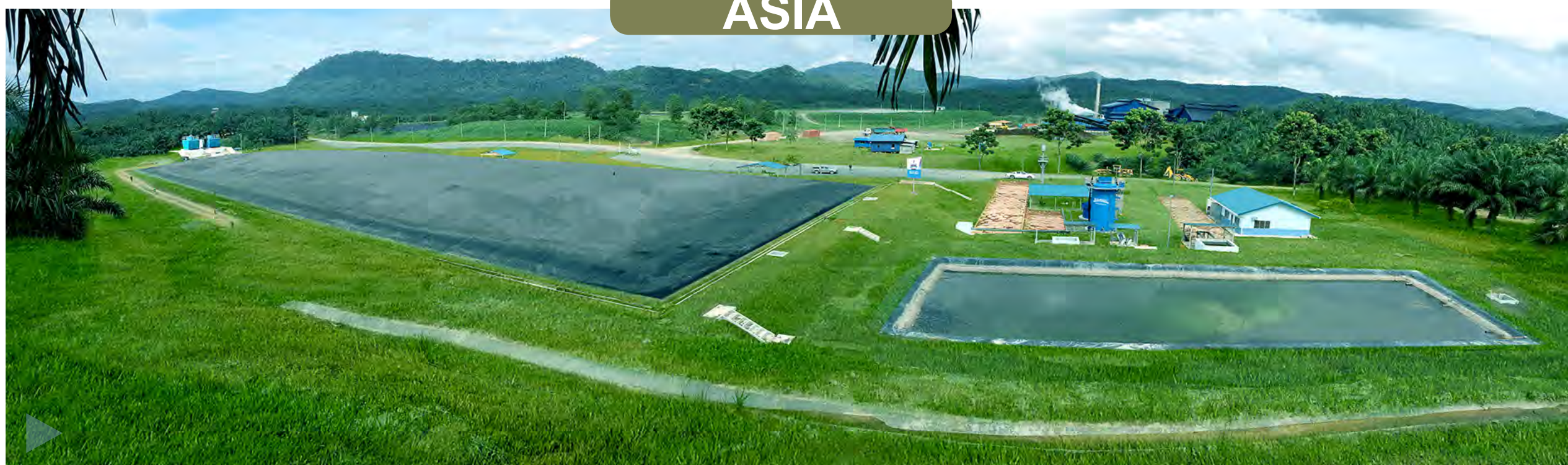
Planta BIOTEC en Extractora Seraya, Sabah, Malasia
