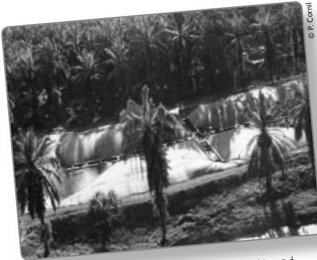
Lagune anaérobie couverte pour la récupération du biogaz à Palmeiras, (Tumaco, Colombie)
